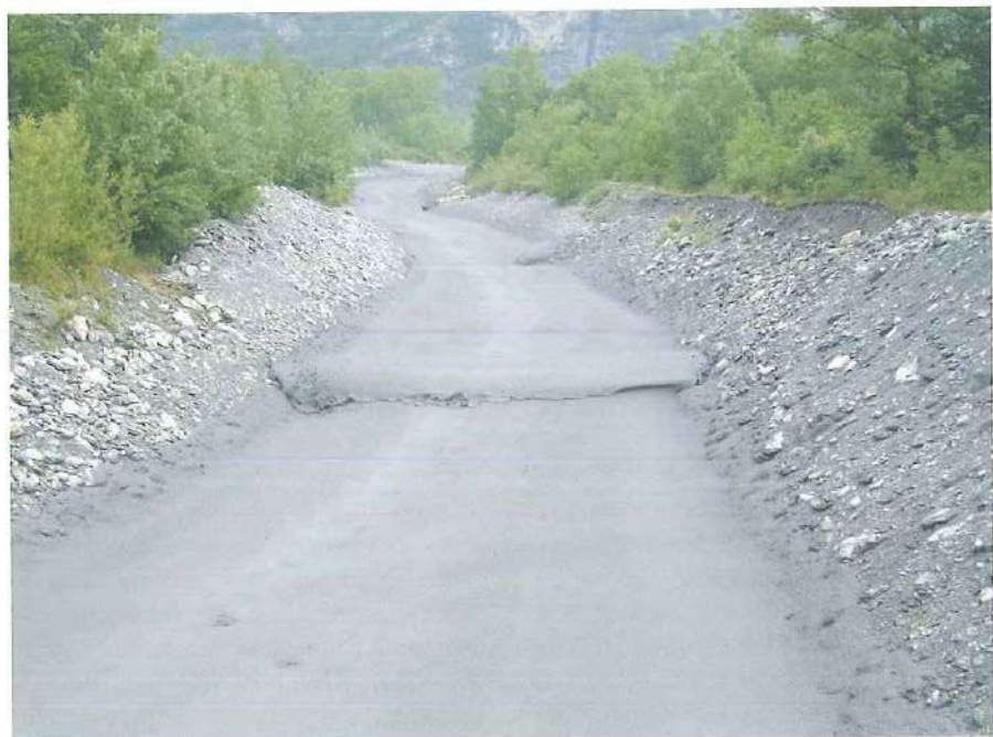
FIG. 1 - Nell'immagine è visibile un fronte pulsatorio di avanzamento della colata detritica del 24 giugno 2006, lungo il tratto in conoide del T. Marderello (Val Cenischia).
