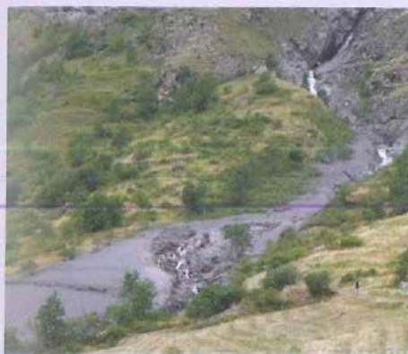
Figura 5.35b - Rivo del Vallone, vista parziale del settore di arresto degli apporti detritici connessi all'evento del 7 agosto.
