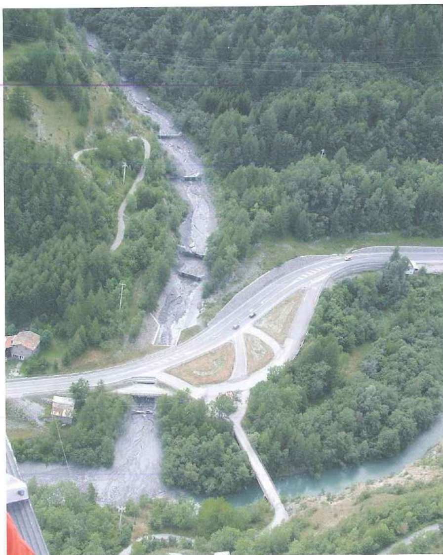
FIG. 6 - A seguito delle intense precipitazioni occorse il 25 luglio 2006 nella zona di testata del Rio Nero (Comune di Oulx) si sono manifestati diffusi fenomeni di instabilità che hanno dato luogo, lungo il reticolato idrografico, ad un ingente processo di colata detritica. Il Rio Nero, raggiunta la confluenza con la Dora di Cesana, ne ha invaso l'asta riversando abbondante materiale detritico e provocando temporaneo invaso per ostruzione al deflusso. By intense rainfall on 25 July 2006 at the catchment's head of the Rio Nero torrent (Oulx, High Dora Riparia Valley), widespread shallow slides along its drainage network originated a huge muddy debris flow. The flowing materials at their inflow in the main stream (Dora di Cesana) temporarily dammed it.
