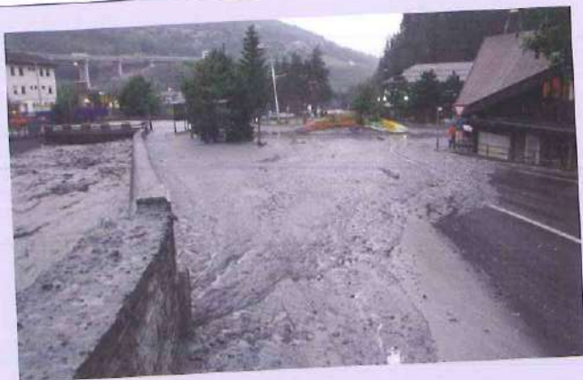
Figura 5.35d - Bardonecchia, settore prossimo all'alveo canalizzato del T. Frejus, alluvionato nel corso dell'evento sia per brusca variazione dell'alveo, sia per esigua luce del manufatto di attraversamento.
