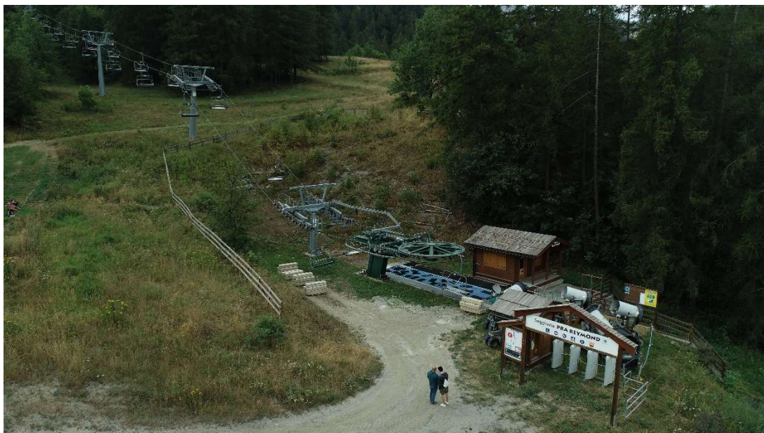
Stazione di valle – rinvio tensione
