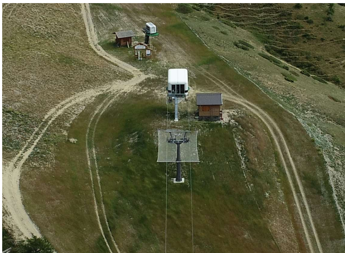
Stazione di monte – motrice argano a ponte
