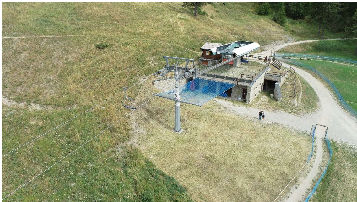
Stazione di monte – motrice argano interrato
