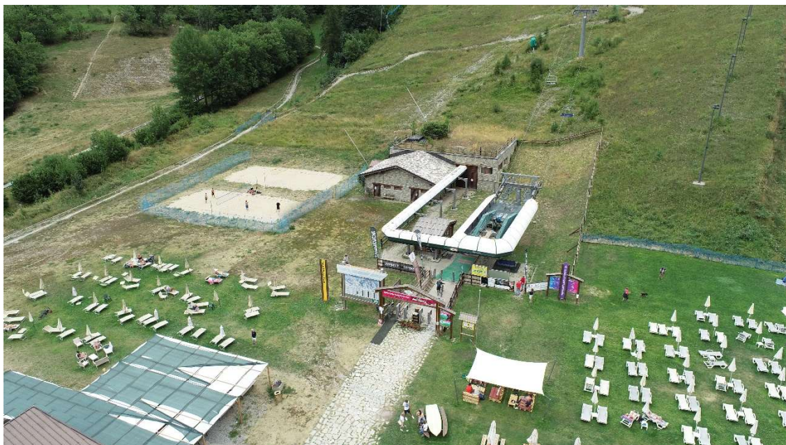
Stazione di valle – rinvio tensione
