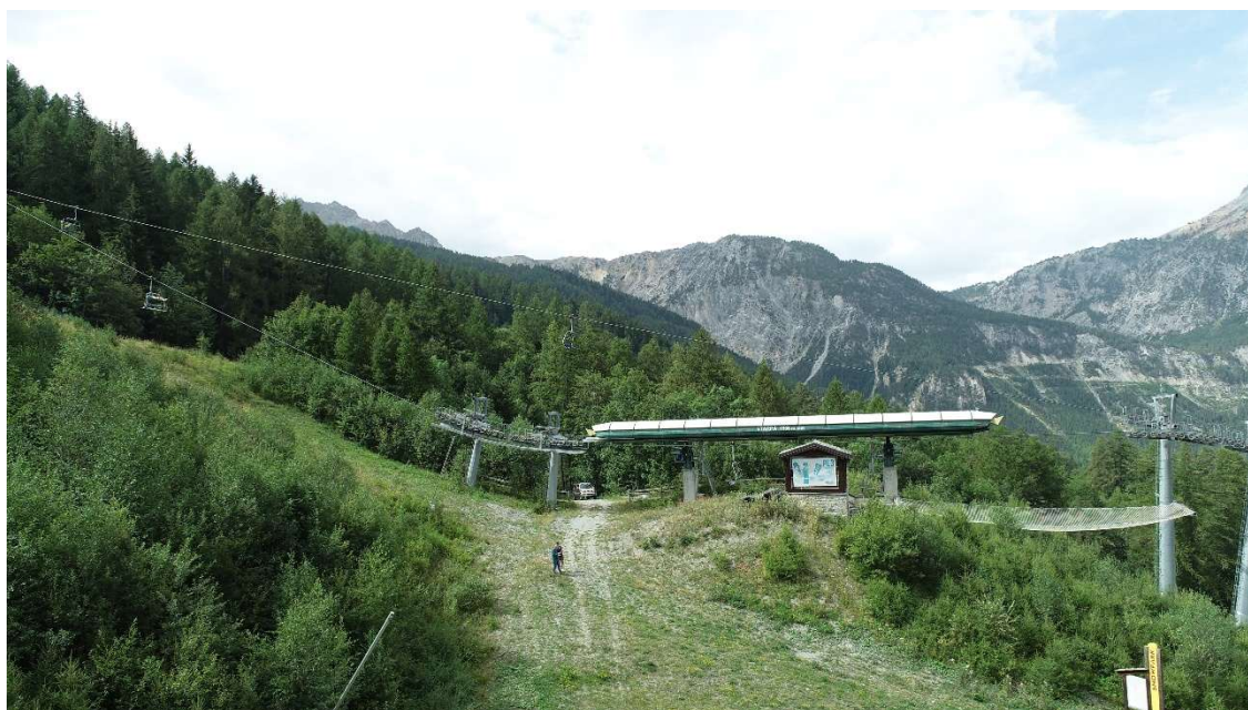
Stazione intermedia – disinseribile – situazione estiva disinserita
