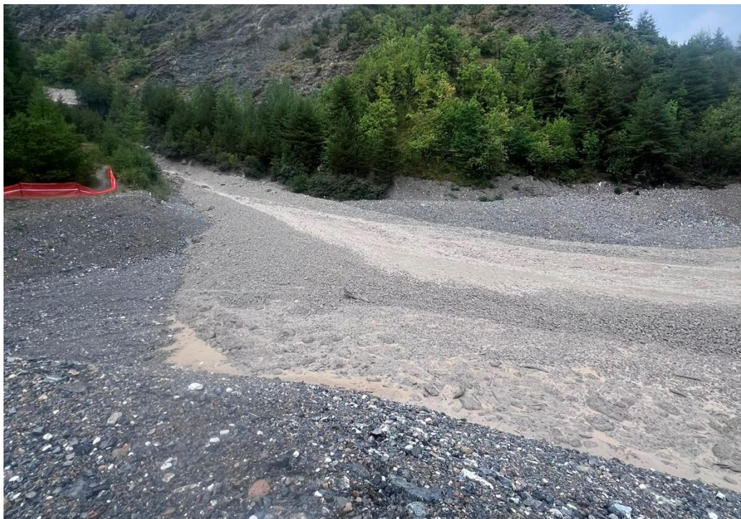
Figura 2: Siaggia di deposito colma di materiale (2)(16/08/2026).
