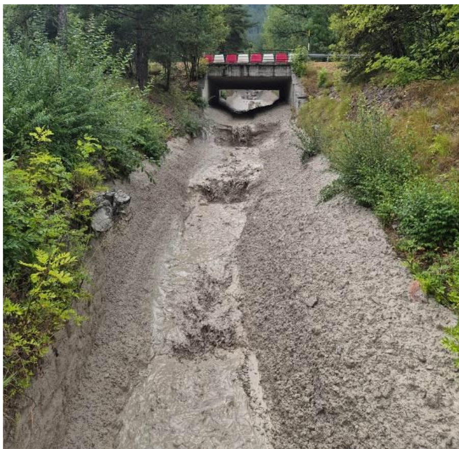
Figura 3: Colata tra il ponte di via della Scala e il ponte SP216 (16/08/2026).
