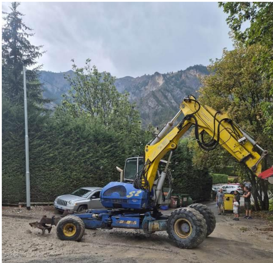
Fig.3 – intervento con escavatore tipo ragno
