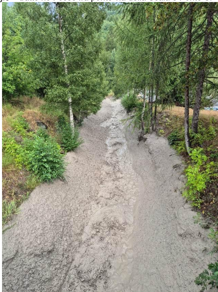
Fig.6 – tratto rio Fosse a monte del Ponte SP 216
