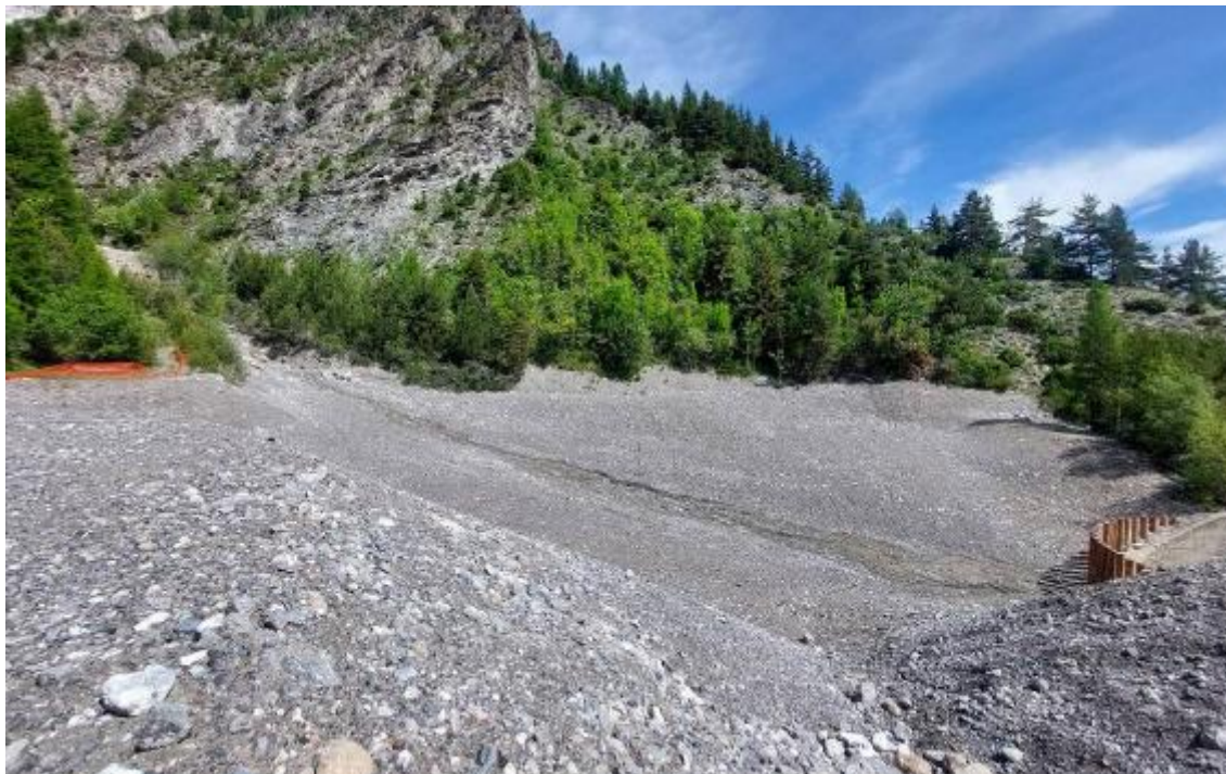
Fig.12 – situazione bacino a tergo briglia rio fosse fotografata nel verbale CFAVS del 19.06.2026 prot. 983
