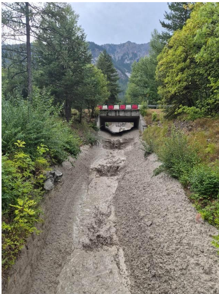
Fig.5 – tratto rio Fosse fra ponte via della Scala e Ponte SP 216
