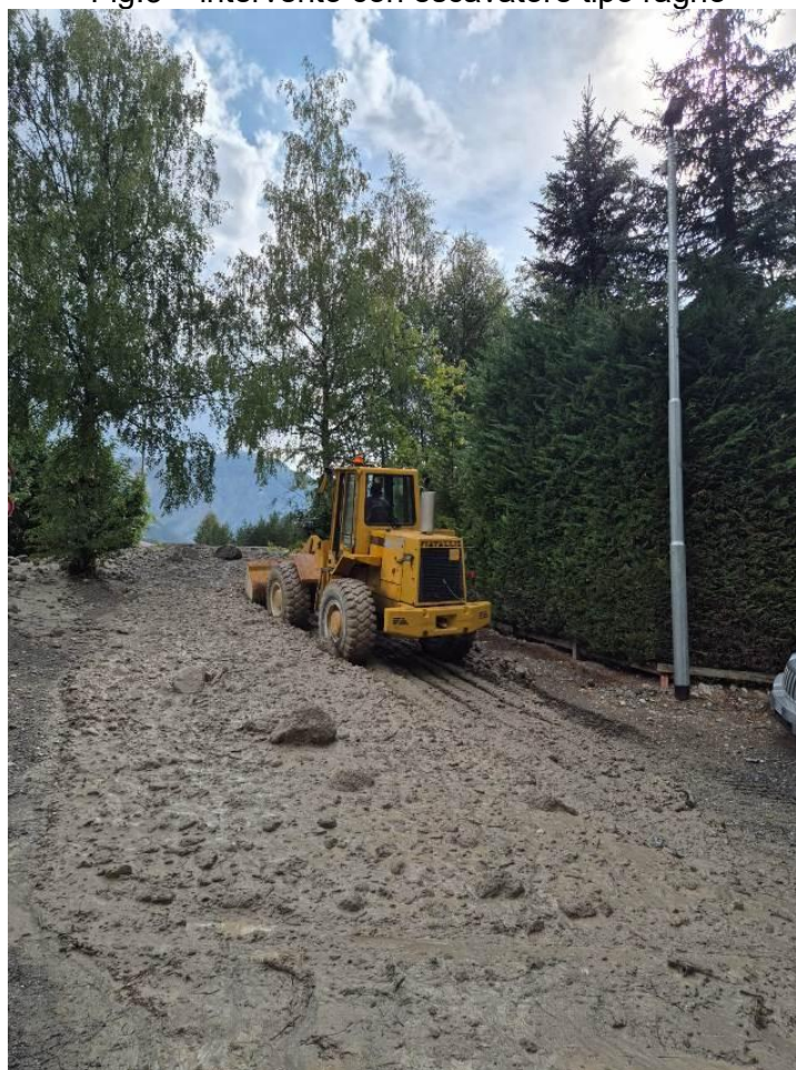
Fig.4 – intervento con pala gommata su area esondata oltre la sponda sx
